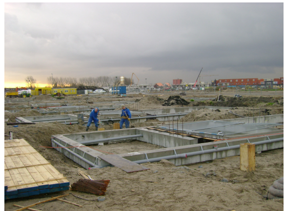
De fundering en installatiewerkzaamheden bij bwnr 17
